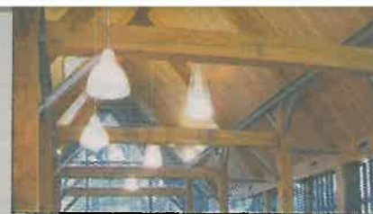
Twee voorbeelden van Marcia Mulder waarin ze oud en nieuw combineert. Links houten gebinten die zijn losgekoppeld en verbonden met stukken ijzer, rechts de buitenkant van gebouw (winkel op landgoed Twickel bij Delden). Een ontwerp uit haar tijd bij Harmonische Architectuur.
